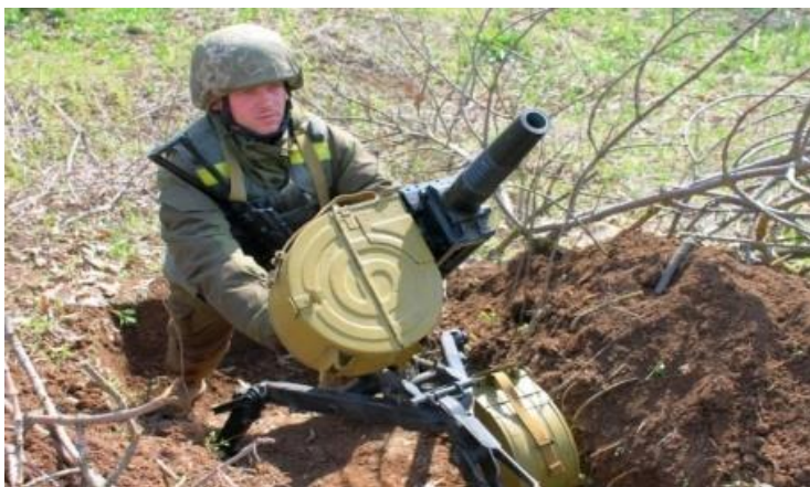
Рис. 4.4. Окоп для стрільби з гранатомета АГС-17: об'єм вийнятого ґрунту 3,2 м 3 ; на облаштування окопу піхотною лопатою необхідно 6 люд.-год, саперною – 3,6 люд.-год
