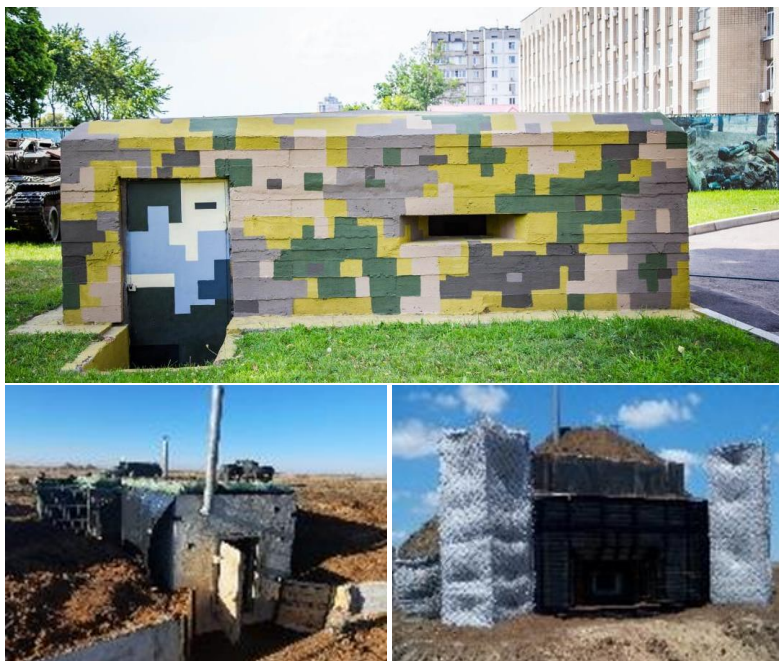
Рис. 4.17. Довготривала споруда для ведення вогню із залізобетонних плит
