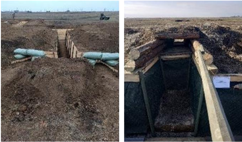
Рис. 4.25. Відкрита споруда для спостереження: об'єм вийнятого ґрунту 14 \text{ м}^3 ; на облаштування окопу саперною лопатою потрібно 16 люд.-год
