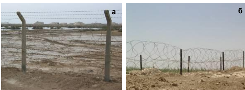
Рис. 3.64. Невибухові загороди при прикритті базових таборів: а – дротяні паркани з колючого дроту; б – загороди з колючого дроту типу "Концентрина"
